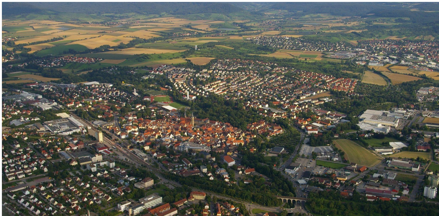
Abbildung 2: Luftaufnahme von Öhringen
